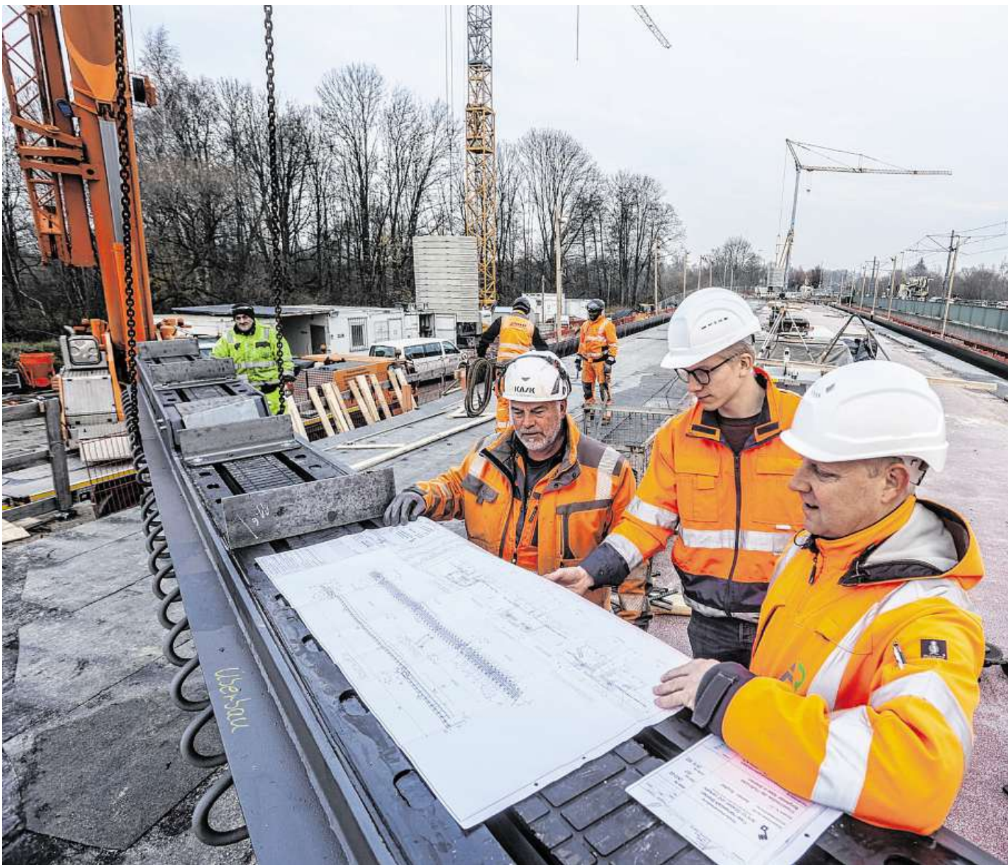
Polier Dieter Schlangen, Brücken-Bau-Chef Jan Hinrik Borchers und Bauleiter Jörg Strudthoff (von links) kurz vor der Fertigstellung der Verbindung zwischen Borgfeld und Lilienthal. FOTO: CHRISTIAN KOSAK
