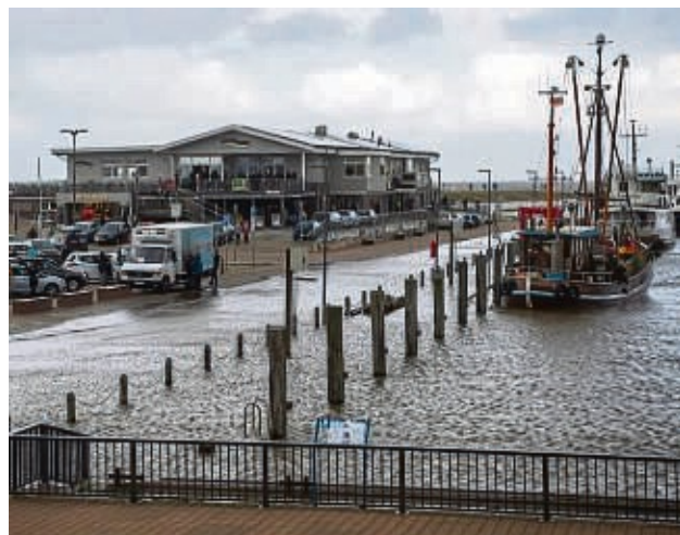
Das Hochwasser hat Teile der Hafenfläche von Harlesiel überflutet.
