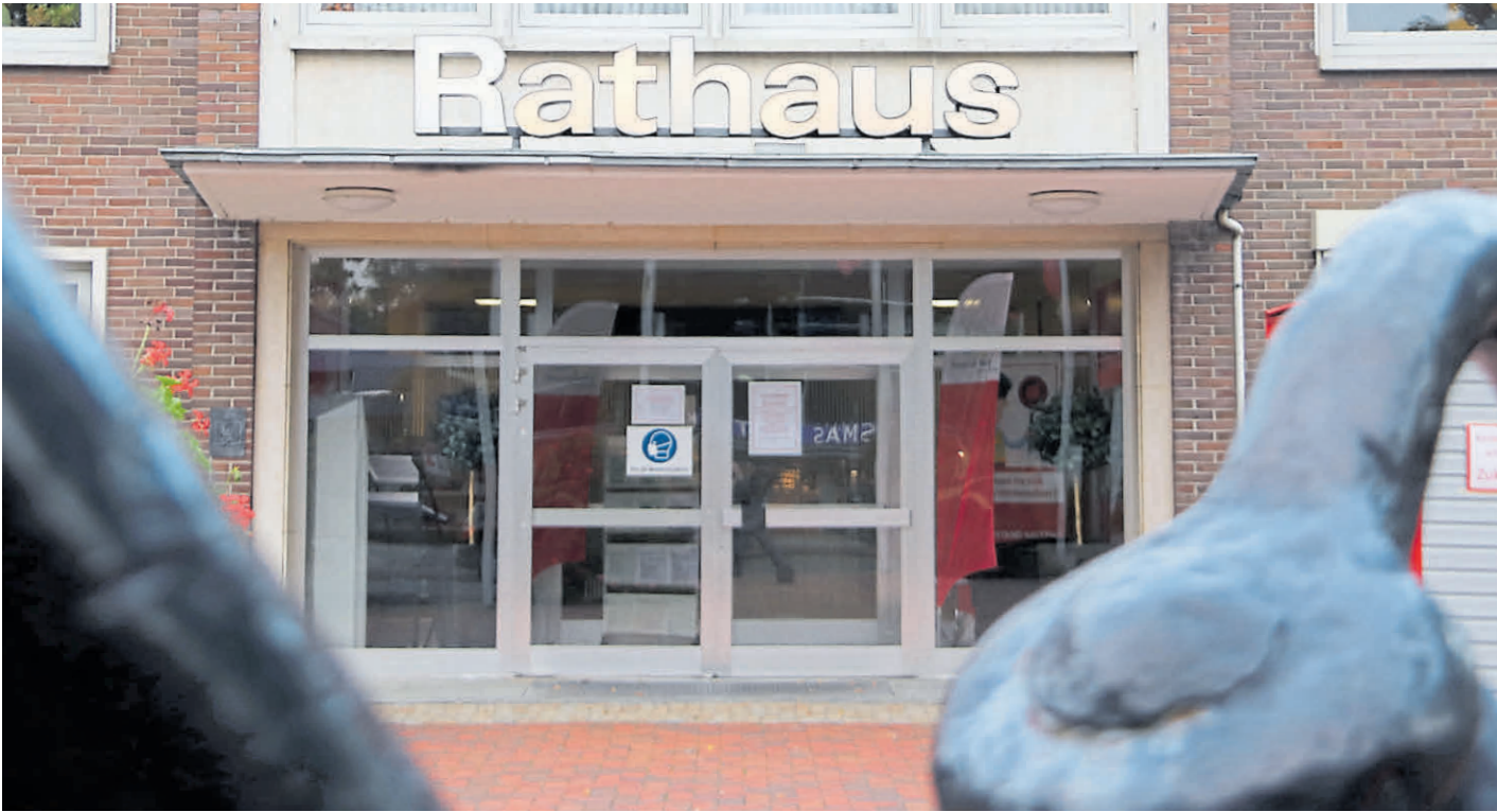
Das alte Rathaus soll weichen: Der Neubau des Rathauses in Barßel soll in zwei Abschnitten stattfinden. Nachdem der neue Verwaltungstrakt gebaut worden ist, soll erst das alte Rathaus abgerissen werden.
