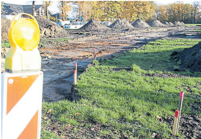
Die Erschließungsarbeiten im neuen Baugebiet „Im Fange II“ sind gestartet.
