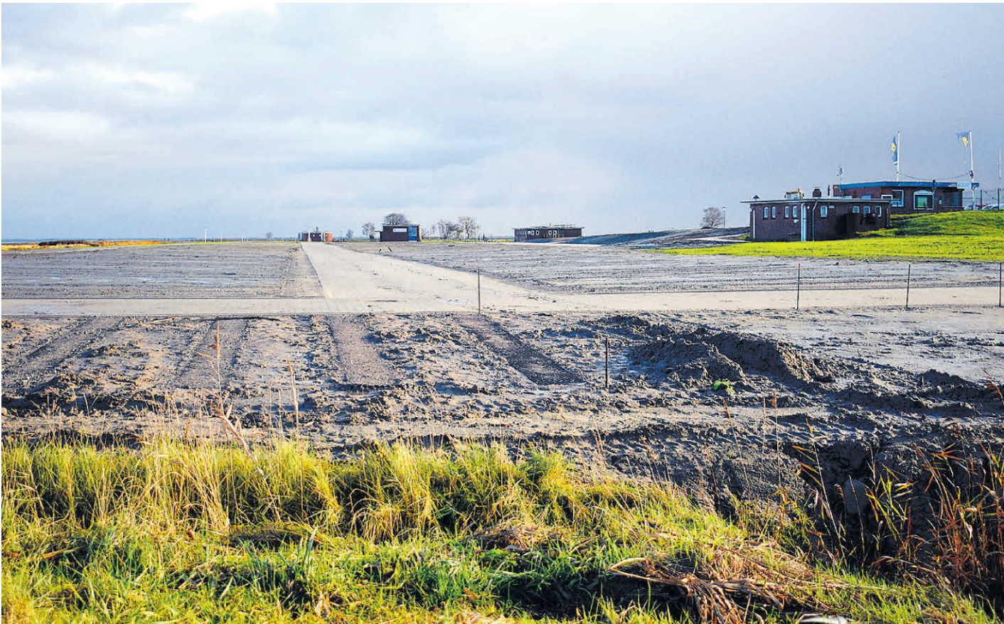
Die Erdarbeiten auf dem städtischen Campingplatz in Dangast sind abgeschlossen. Die Hochbauarbeiten folgen im nächsten Jahr.
