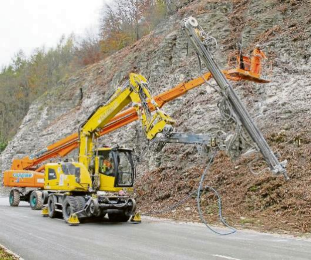
Die Bohrungen haben den Zweck, die Belastbarkeit für die Hangsicherung zu prüfen.
