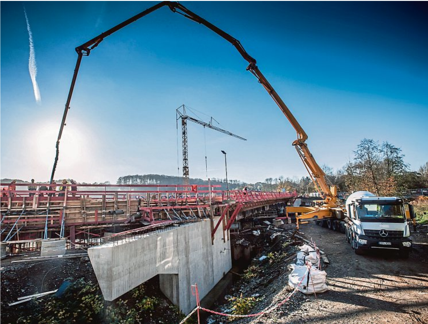
Über eine riesige Betonpumpe wird die graue Masse auf das Brückengerüst befördert. Fotos: Ralf Krieger
