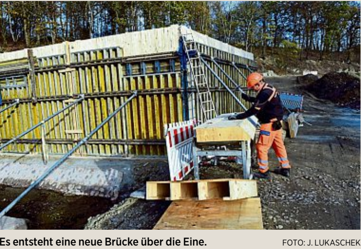
Es entsteht eine neue Brücke über die Eine. FOTO: J. LUKASCHEK
