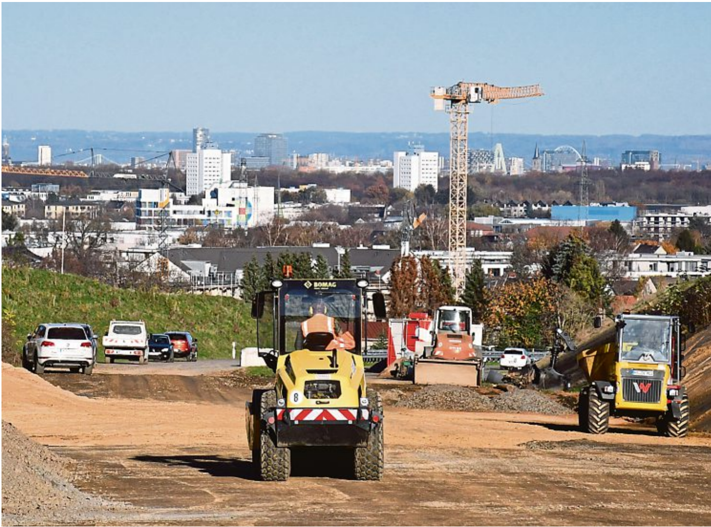
Der Boden im Bereich der künftigen Anschlussstelle in Kendenich muss verdichtet werden.
