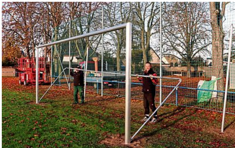
Matthias Persdorf und Stefan Vogel von der Barthel Sportstätten Service GmbH aus Dreieheide/Großwig in Nordsachsen führen die Arbeiten auf dem Sportplatz in Prettin aus.
