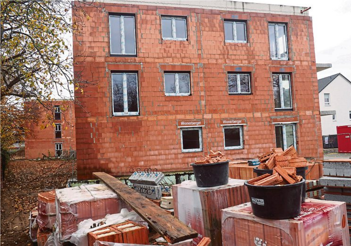
Ende des Stillstands: Die Arbeiten an den Häusern im Blumenquartier sollen in Kürze weitergehen.
