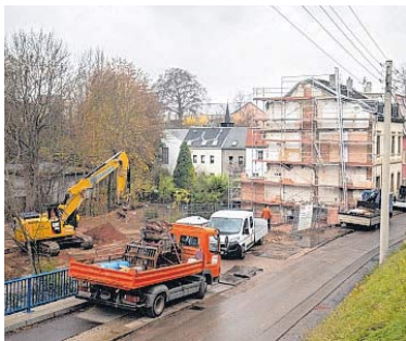
Nach dem Abriss der beiden Wohnhaus-Ruinen werden die Flächen nun umgestaltet. FOTO: MARKUS PFEIFER
