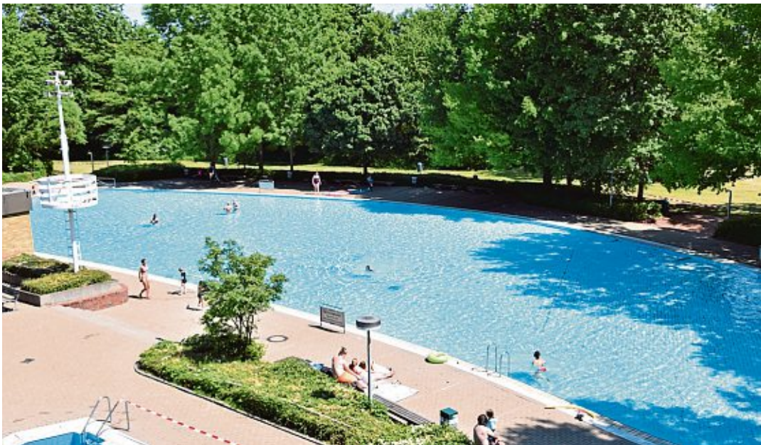
Das Land gibt Geld für das Terrassenfreibad in Frechen. Geplant ist, alle Becken zu sanieren. Foto: Höhne
