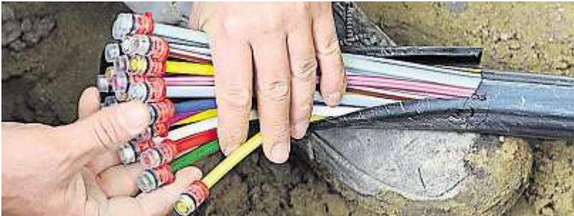
Die Häuser sollen Glasfaseranschlüsse erhalten.
