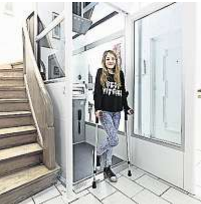
Barrierefrei bauen: Ein Aufzug im Haus kann allen Altersgruppen Erleichterung bieten. FOTO: TELGTE HELLER/DPA
