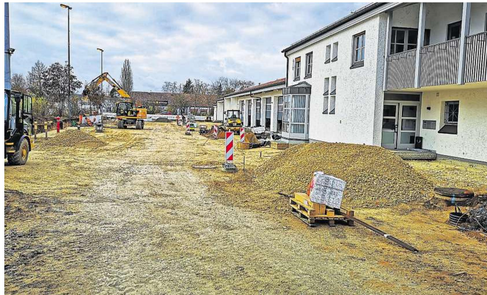
Bauarbeiter haben am Hof vor dem Feuerwehrgerätehaus den Frostschutz eingebbracht, den Kanal erneuert und Stromleitungen verlegt. FOTO: SIEGLINDE GEIPEL
