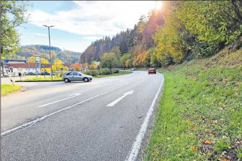
Die Strecke vom Gewerbegebiet in Richtung Thaleischweiler-Fröschen ist ab Montag gesperrt. Dann beginnen die Arbeiten an der L 477. FOTO: ANDREA DAUM
