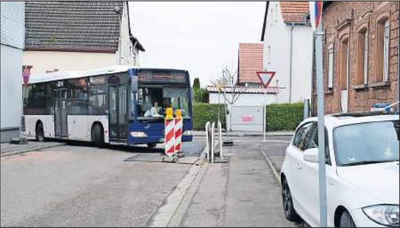
Der Stadtbus aus Gersbach biegt in die Oskar-Metz-Straße ein: die momentane Baustelle ähnelt als Hindernis den in der Vergangenheit auf dem Bürgersteig geparkten Fahrzeugen, weswegen der Bus hinten über den Randstein fahren muss.
