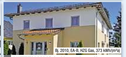
Bj. 2010, EA-B, HZG Gas, 373 kWh/(m 2 a) NITTENAU Vielseitig nutzbares Haus, ca. 205 m 2 Nutzfläche, 10 Zimmer. Corinna Storbeck NKM-Preis auf Anfrage**
