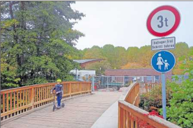
Die Bleicherbachbrücke ist marode. Der Oberbau soll demnächst erneuert werden. FOTO: MOSCHEL
