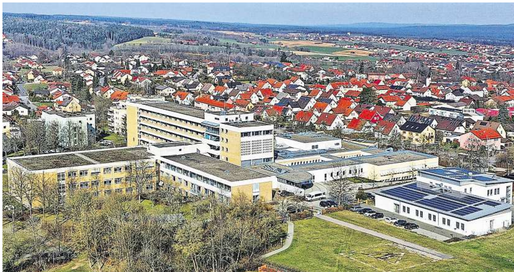
Gesundheitscampus statt Krankenhaus: Die Planungen für den Standort Roding werden forciert. Der genaue Zeitplan ist aber noch unklar.
