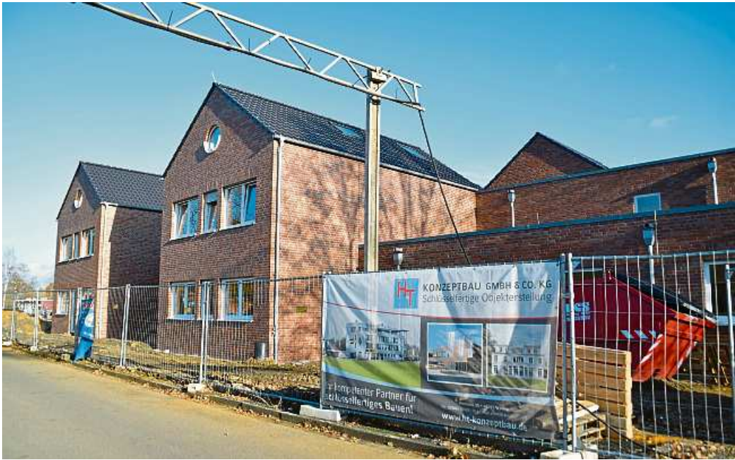
Die Kita Seestern am Rohrkamp nimmt im Januar 2021 ihren Betrieb in dem Neubau auf. Dann ist die Zeit in den Containern vorbei.
