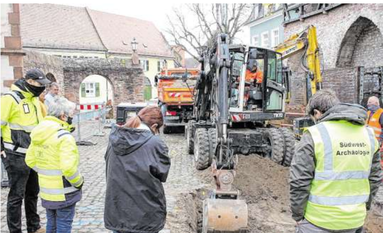
Ein größeres Stück römischer Wandputz ist bei den Vorarbeiten zur Sanierung der Kirchenstraße (im Hintergrund) zutage getreten. BILD: PETER JASCHKE
