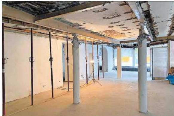
Zwei Sorten Pfeiler: Links Teleskopsprieße für die darüber liegende Wand, rechts Metallstützen mit ornamentalem Kopf. FOTO: YNS
