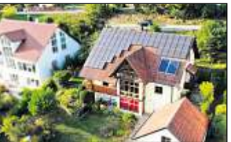
Bedarfsausweis: Endenergiebedarf kWh/(m²a): 140,30, Zentralheizung, Ölheizung, Fußbodenheizung, Baujahr: 1989, Energieklasse: E
