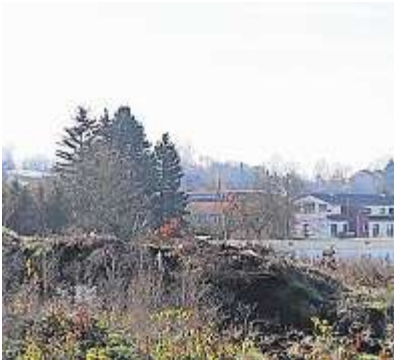
Am Gutenbergring werden drei Häuser entstehen. FOTO: GABI HUEBER-LUTZ
