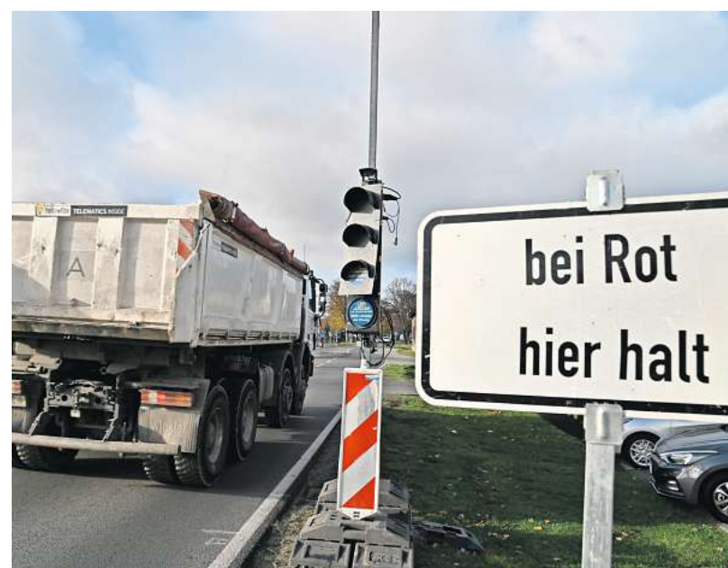
Eine Ampel wird in der kommenden Woche den Verkehr in Höhe des Globus-Baumarktes regeln. Grund dafür sind Bauarbeiten. FOTO: ROBERT ROESKE
