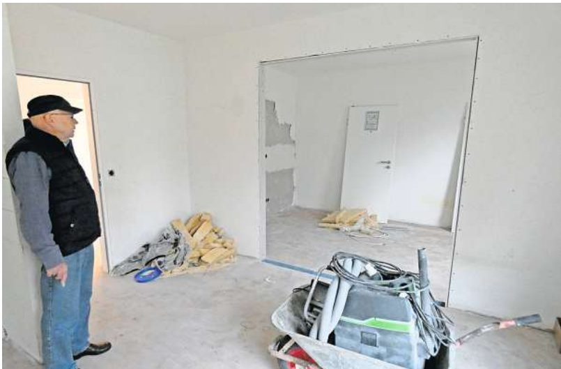
Eckhard Kuhn in einer der Wohnungen. Zwischen Küche und dem Wohnzimmer gibt es teilweise Durchbrüche.
