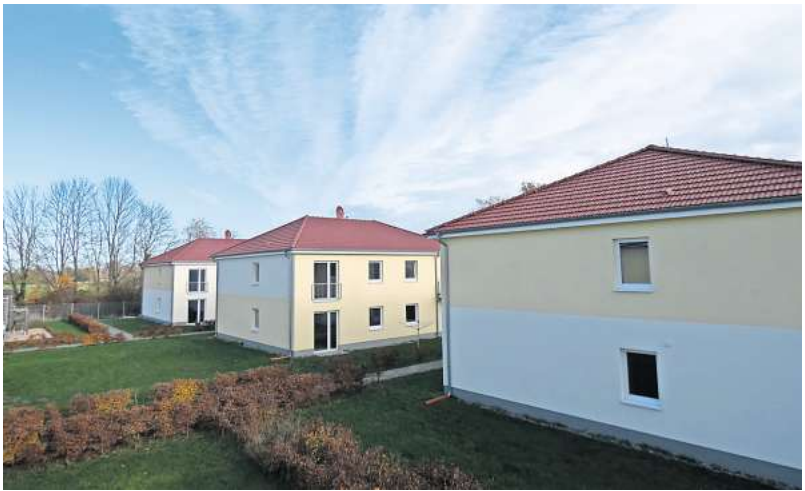
Die Wohnanlage mit den neuen Häusern bietet viel Grün. Um den Garten will sich die Woba kümmern.
