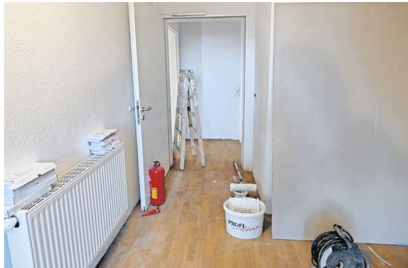
Ein Drittel der Häuser sind bereits fertig. In den anderen sind noch die Handwerker unterwegs.
