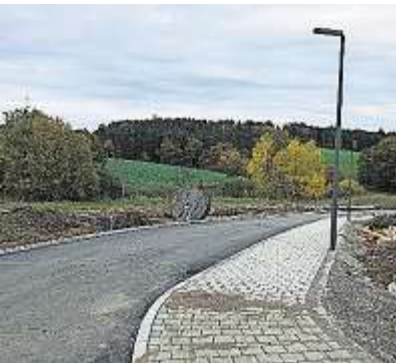
Rund um den Michael-Zenger-Ring werden die 31 neuen Baugrundstücke platziert. FOTO: HERRMANN
