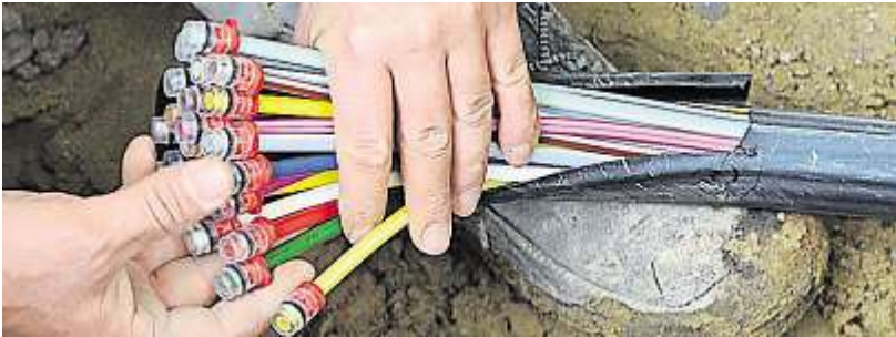
Die Häuser sollen Glasfaseranschlüsse erhalten. FOTO: PETER KNEFFEL/DPA
