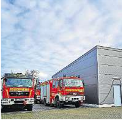
Fahrzeuge der Feuerwehr sind während der Bauarbeiten auf dem Gelände des Abwasserzweckverbandes an der Dr.-Pfannenstiel-Straße abgestellt. FOTO: SIEGLINDE GEIPEL
