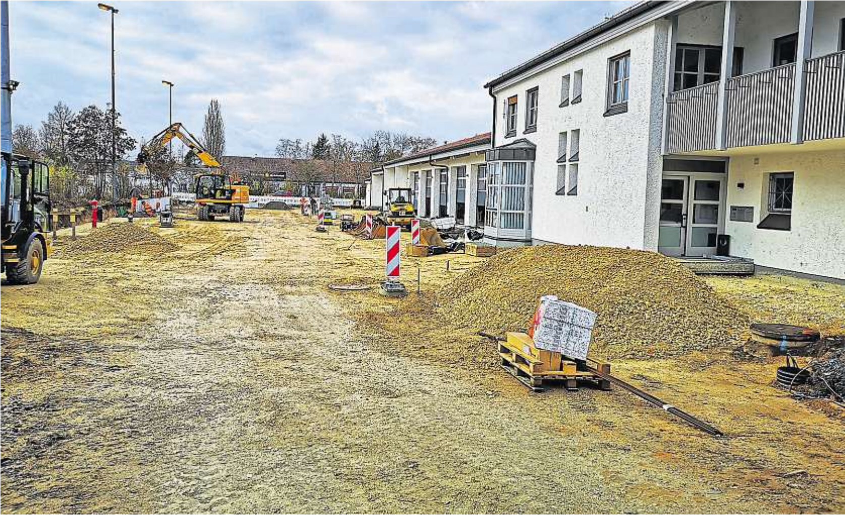
Bauarbeiter haben am Hof vor dem Feuerwehrgerätehaus den Frostschutz eingebracht, den Kanal erneuert und Stromleitungen verlegt. FOTO: SIEGLINDE GEIPEL
