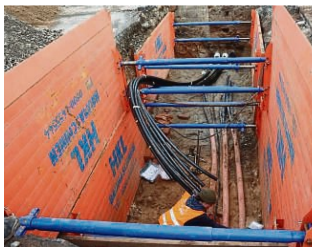
Neue Stromleitungen als Ersatz für die alten Kabel, die gefunden – und versehentlich durchtrennt – wurden.
