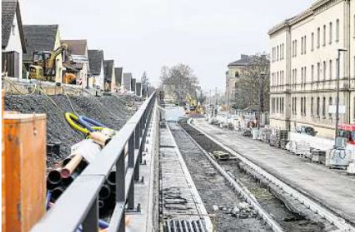
In der Nürnberger Straße wird seit Längerem gebaut. Aktuell ist der Abschnitt an der Faulenbergkaserne dran. FOTO: THOMAS OBERMEIER
