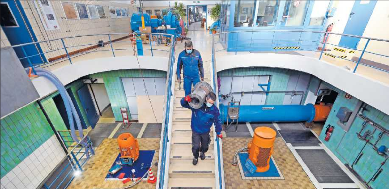
Zeit für einen Wechsel: Im Wasserwerk I werden die vier Netzpumpen ausgetauscht.
