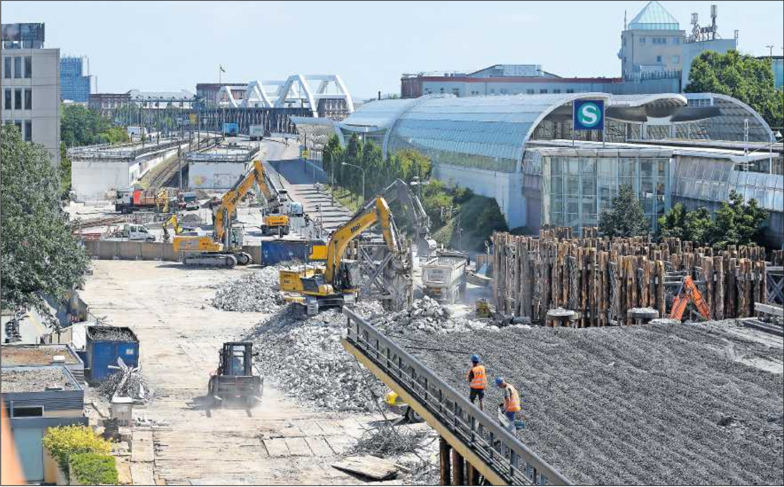
Ab 22. November war die Verbindung zwischen Mitte und Süd dicht. Der Hochstraßenabriss startete im Juni und dauerte 106 Tage. ARCHIVFOTO: MORAY
