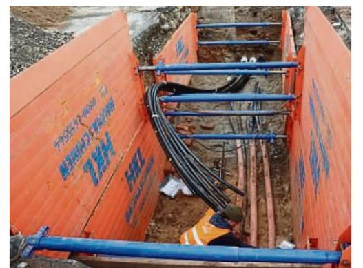
**Neue Stromleitungen** als Ersatz für die alten Kabel, die gefunden – und versehentlich durchtrennt – wurden.
