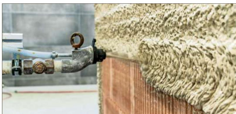
Mit dem Produkt „Spritzbare Fassadendämmung mit Glass-Bubbles“ ist Maxit für den Preis nominiert.
