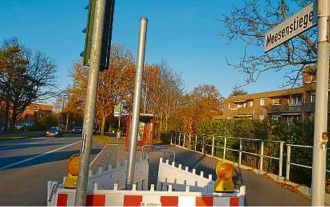
Die Haltestelle Franz-Berding-Weg an der Meesenstiege wird für einige Wochen verlegt. Foto: gro
