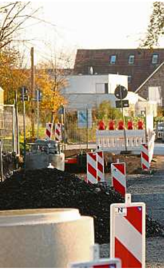
Kanalarbeiten an der neuen Middeler Straße. Foto: mlü
