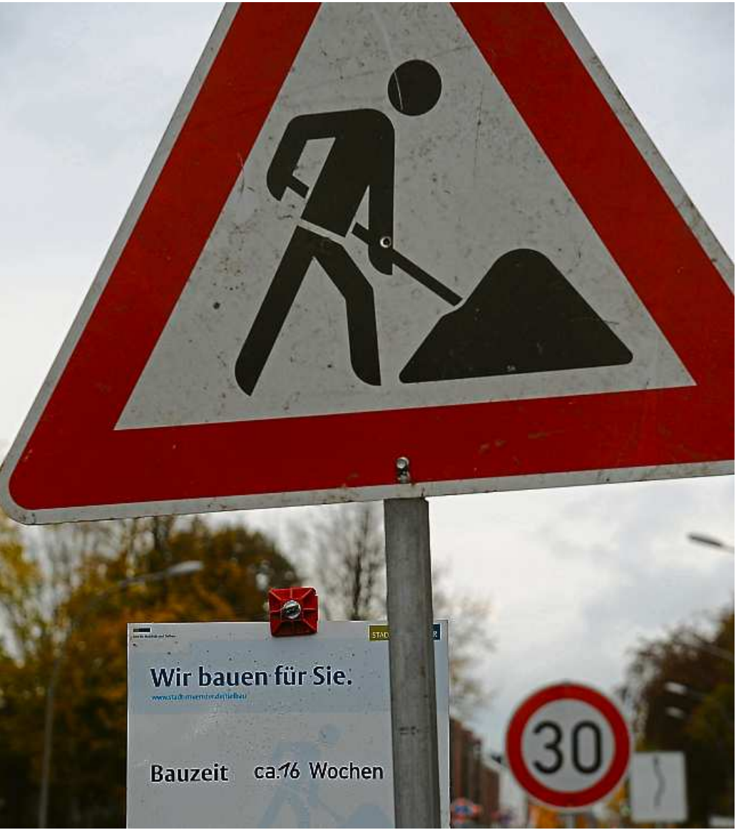
Dauerbaustelle Westfalenstraße: Streit zwischen den Ämtern sorgte für Verzögerungen.
