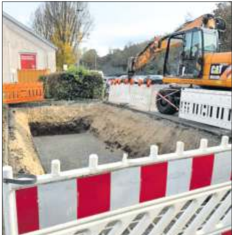
Eine relativ große Grube ist nötig, um den Platz für die unterirdischen Behälter zu schaffen.
