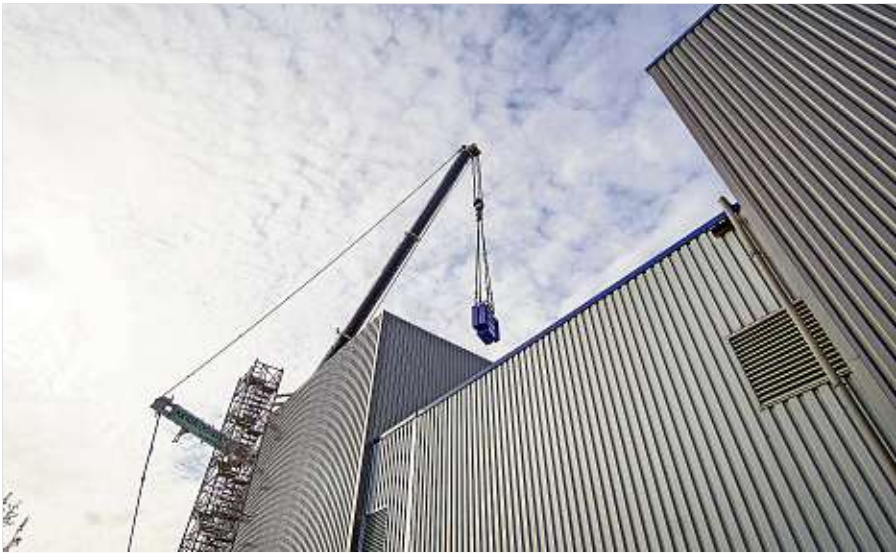
Ein riesiger Kran hievte die Teile für den neuen Elektronenbeschleuniger über die jüngste Werkhalle von Ionisos. Foto: SZ/Uwe Soeder
