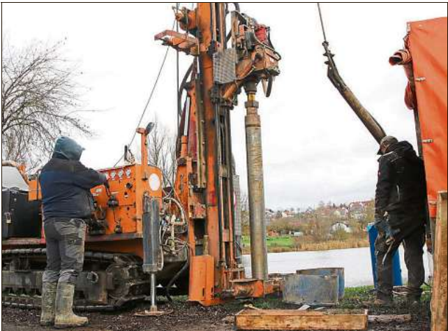
Durch eine Bohrung wird die Zusammensetzung des Damms ermittelt.
