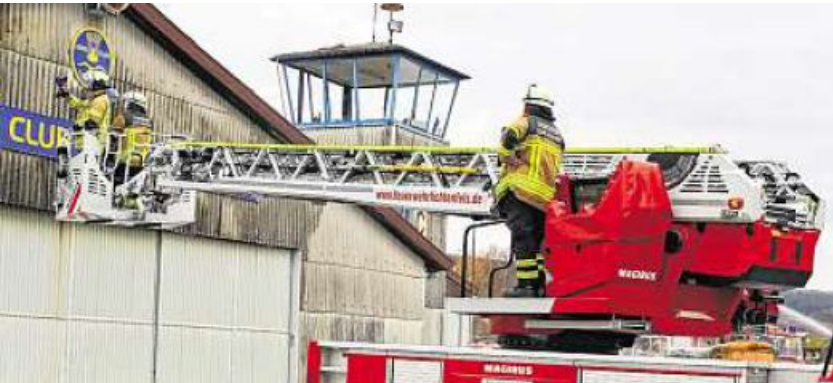
Mit Drehleiter und Wärmebildkamera untersuchen die Feuerwehrmänner die Außenhaut und das Dach des Flugzeughangars.
