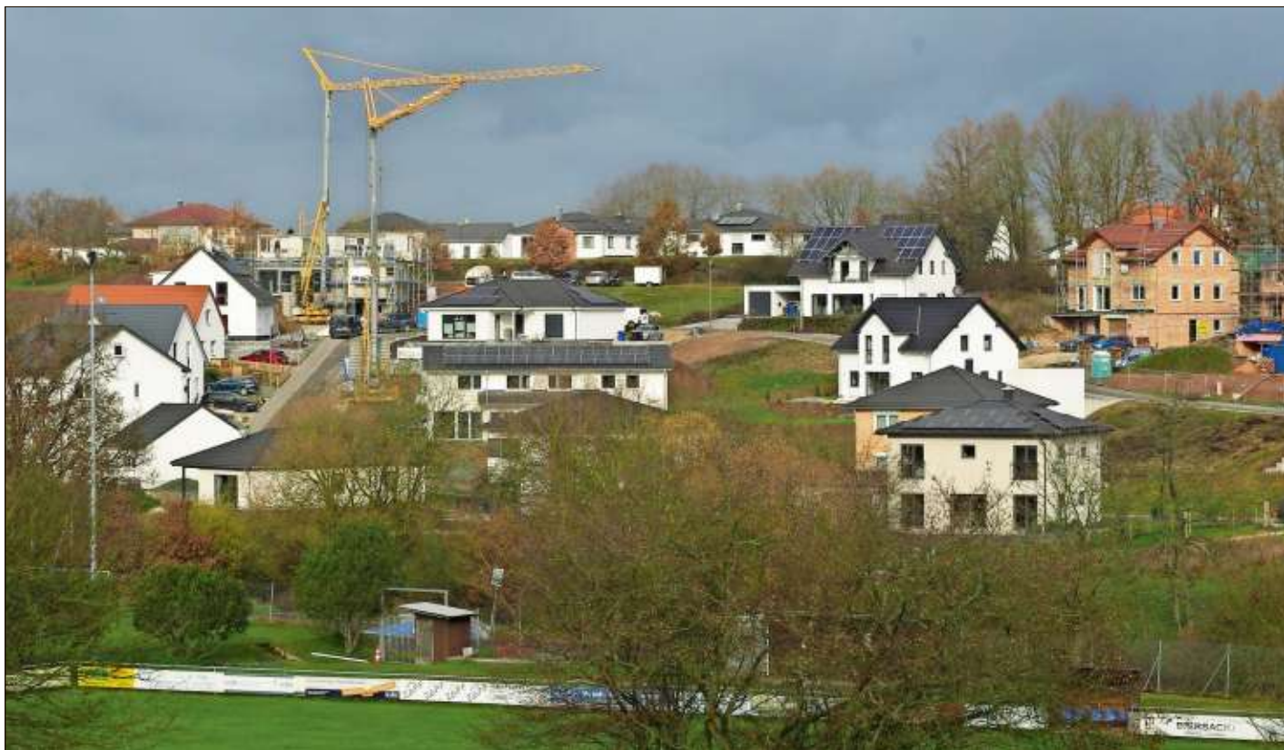
Bauboom: Ein Teil des Neubaugebietes Sonnenleite in Creußen, es umfasst insgesamt eine Fläche von fünf bis sechs Hektar und bietet Platz für 44 Häuser. Die meisten der Häuser stehen bereits. Baubeginn war 2018. Unten ist der Sportplatz mit Bänken zu sehen. Foto: Peter Engelbrecht
