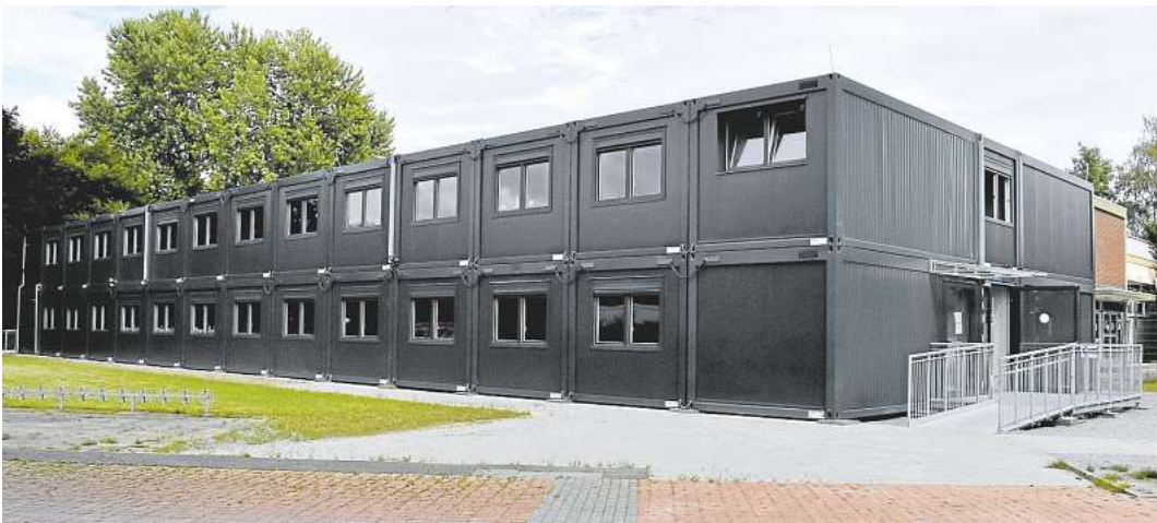
70 Container wurden für die Oberschule aufgebaut. Doch es gab eine Reihe von Problemen. FOTO: BS
