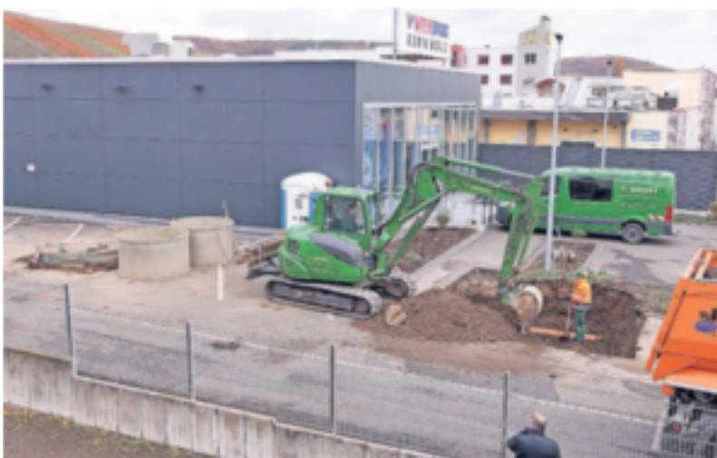
Nur zehn Meter liegen der erste Fundort (links abgedeckt) und die zweite Sondierungsstelle auseinander.
