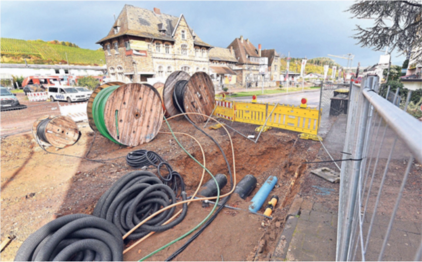
Auch am Bahnhofsvorplatz in Bad Neuenahr wurden bereits im Zuge der Neugestaltungsarbeiten Fernwärmeleitungen gelegt.
