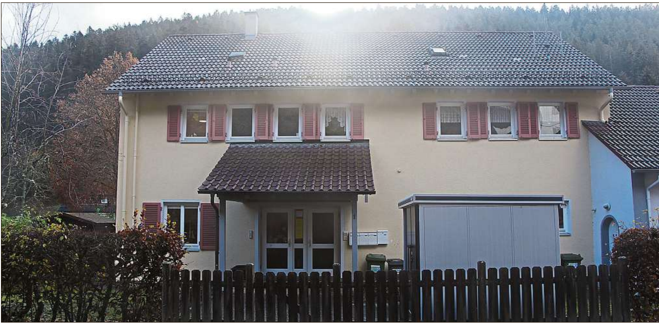
Besagtes Gebäude in der Badstraße in Bad Teinach soll zu einem reinen Kinderhaus umgebaut werden. Das kostet viel Geld. Foto: Buck
