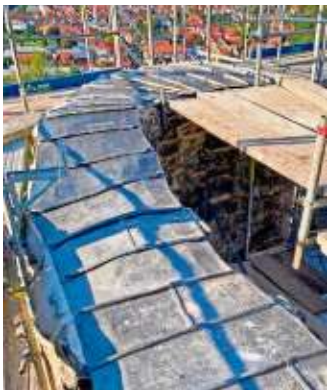
Neue Abdeckung der Mauerkrone des Palas mit Bleiblech.
