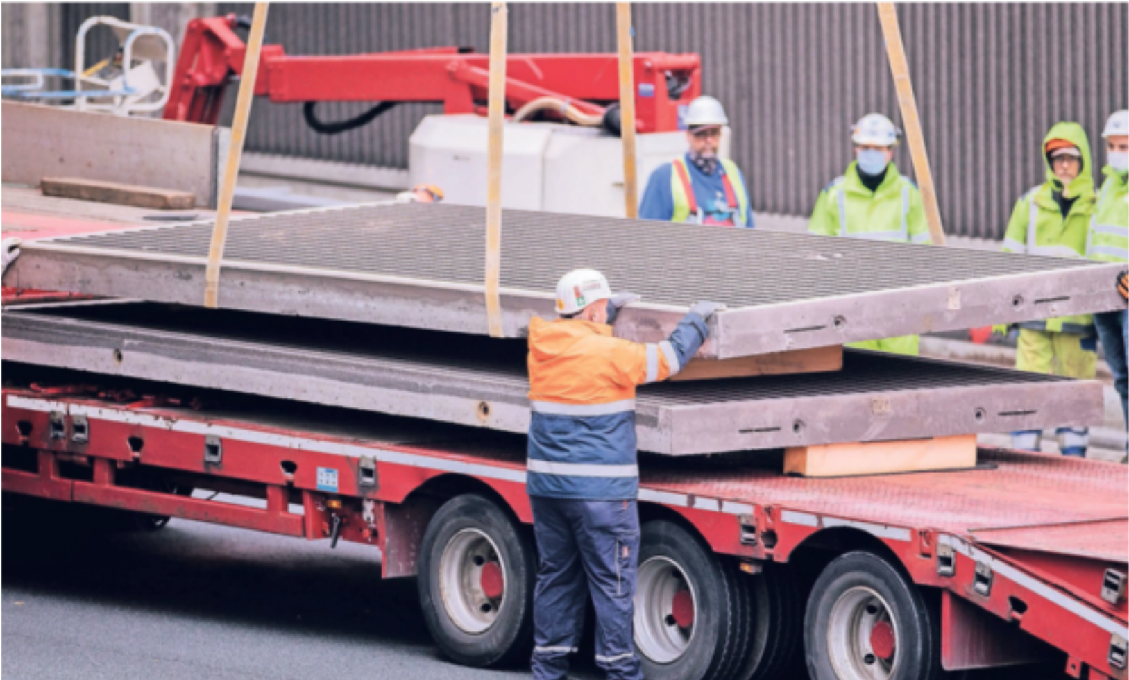
Eine zweite entfernte Betonplatte wird auf der A3 auf einen Tieflader verladen. Knapp eine Woche nach dem Sturz einer Betonplatte auf das Auto einer Kölnerin wurden nun sechs weitere abgenommen. Auch sie waren ebenfalls falsch befestigt.
