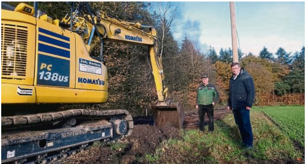
Der Bagger ist seit Montag in Aktion. Hartmut Menkens (l.) beaufsichtigt die Arbeiten vor Ort, Bauamtsleiter Uwe Kläner kommt regelmäßig vorbei.
