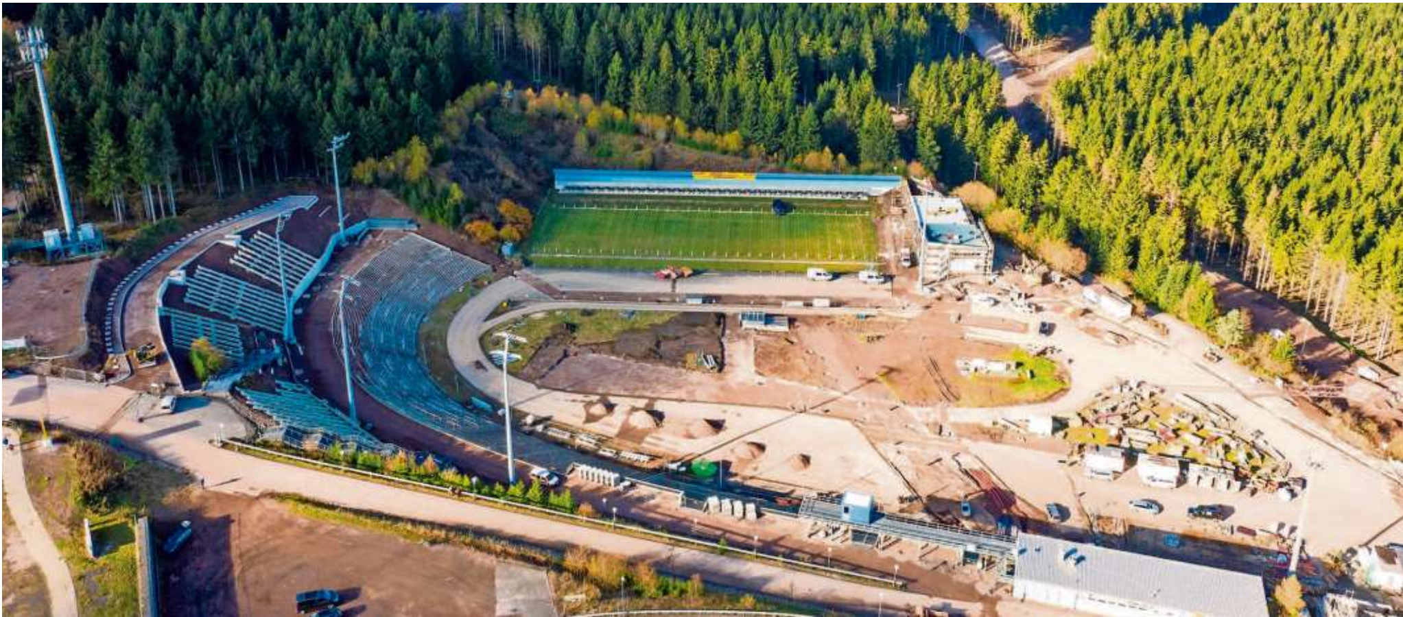
Besser als der Blick aus dem Fenster: Die sich im Umbau befindende Oberhof-Biathlon-Arena, aufgenommen mit einer Drohne. Auffallend hierbei: Die Fundamente für die mobilen Tribünen, die den Stadioncharakter noch verstärken werden (links), das neue Schießstandgebäude rechts neben dem Schießstand, das die Windeinflüsse spürbar verändern dürfte, sowie die regen Bautätigkeiten an der Strecke (Schneise rechts). Bis Ende dieses Monats soll die Baustelle für den Doppel-Weltcup im Januar zurückgebaut werden.
