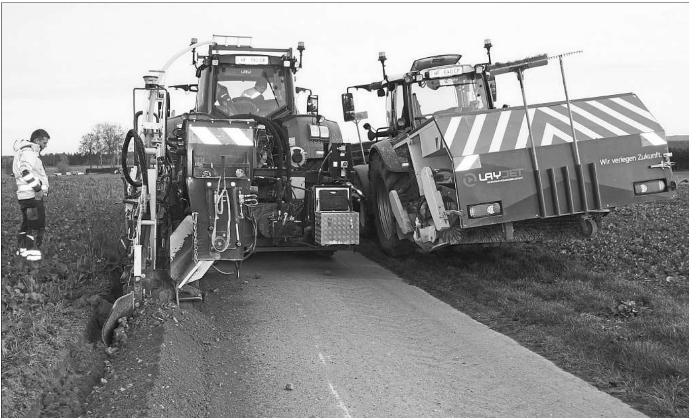
Einem kleinem technischen Wunderwerk gleicht das Fahrzeug der Firma Lay Jet, das bei Hart Leerrohre für den Aufbau des landkreisweiten Backbone-Netzes in den Boden einzog. Binnen vier Tagen waren die Arbeiten erledigt.
