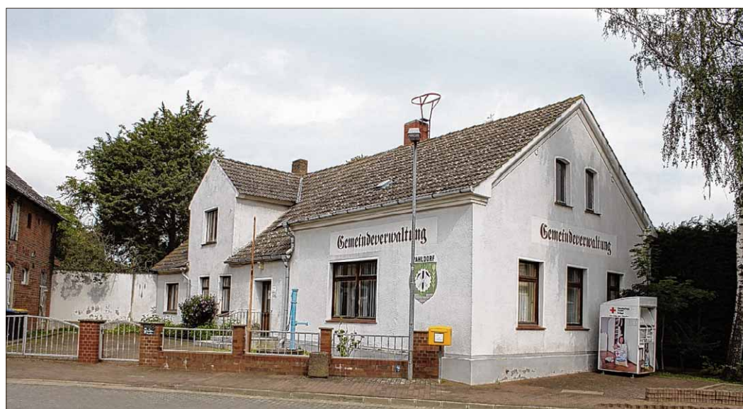
Die Sanierung des Bürgerhauses in Vahldorf würde über 300 000 Euro verschlingen und wäre für die Gemeinde zu teuer.
