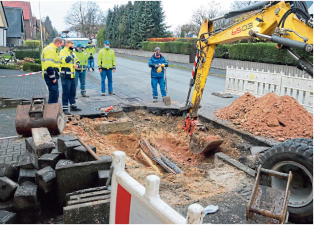
Um den Fehler am Stromkabel zu suchen, wird das Erdreich an der Detmolder Straße aufgegraben. Dabei entdecken die Bauarbeiter, dass hier auch Gas aus der Hauptleitung austritt.
