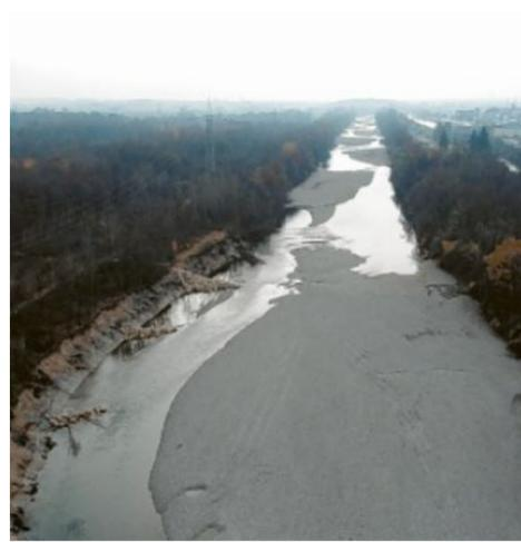
Ein Novemberbild vom Lech. Deutlich wird hier: der Fluss ist schnurgerade wie sein rechts neben ihm fließender Kanal. Das was der Fluss hier vom Ostufer abnagte, sind 40 Meter, um die er sich in diesem kurzen Abschnitt verbreitert hat.
