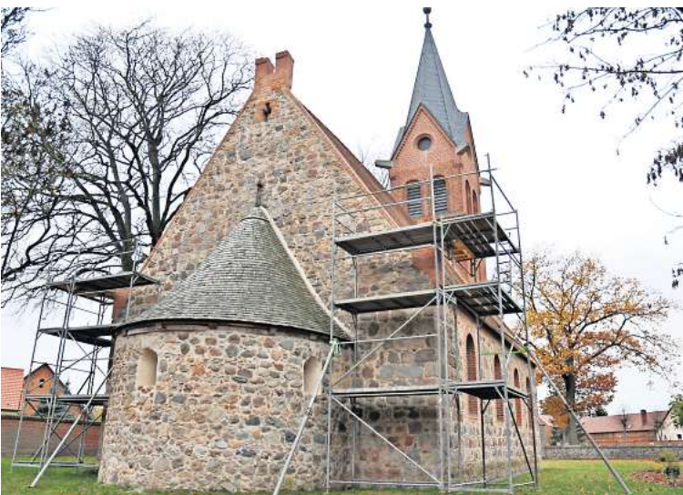
Sie ist die älteste Kirche der historischen Prignitz und stammt aus der Zeit um 1250: Die Feldsteinkirche in Wernikow hat sich seit 2015 zu einem Schmuckstück entwickelt. Die Zinnen am Ostgiebel erhalten nun neue Fugen.
