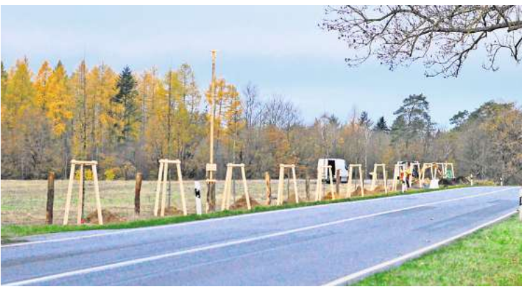
Mehrere Bäume werden entlang der B103 gepflanzt.
