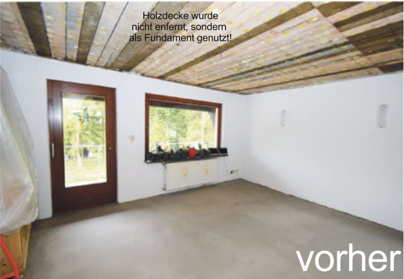
Vorher: Holzdecke im Wohnzimmer nach der Entfernung der Styroporplatten. Vor dem Einbau der Spanndecke wurde eine Dampfsperre vom Dachdecker montiert.
